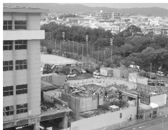
市民会館解体中
